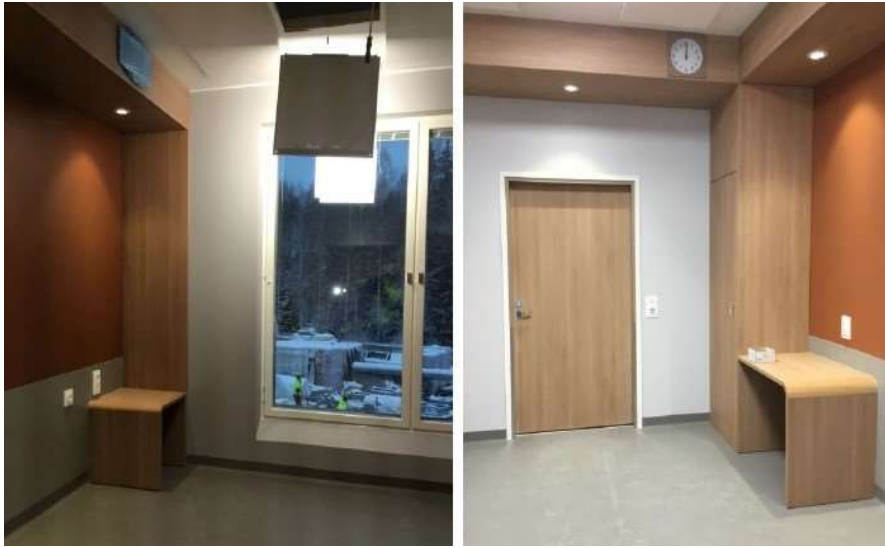
Kuvat 3-4. Potilashuoneen malliasennus valmistui katselmoitavaksi B-lohkolla. (kuvattu vuoden 2021 lopulla, tila 2.518/T)
