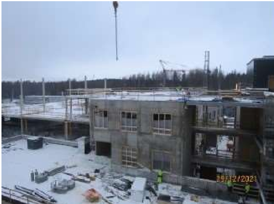
Kuva 8. Rakennustyöt A-lohkolla, jossa rungon pystytys valmistuu viimeisenä, vuoden 2021 lopussa mallihuoneiden sisällä jo valmistuessa.
