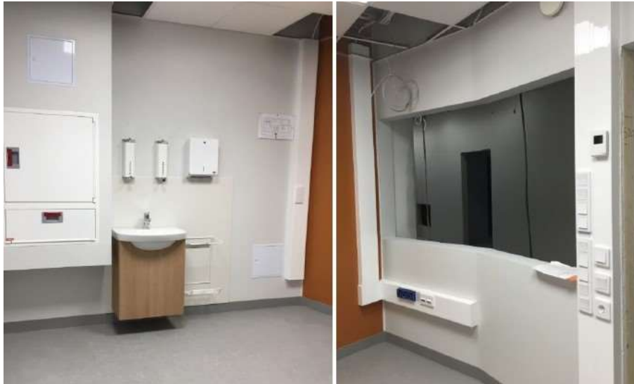
Kuvat 6-7. Toimistohuoneen malliasennus valmistui katselmoitavaksi vuodenvaihteessa. (kuvattu vuoden 2021 lopulla, tila 1.520/T)
